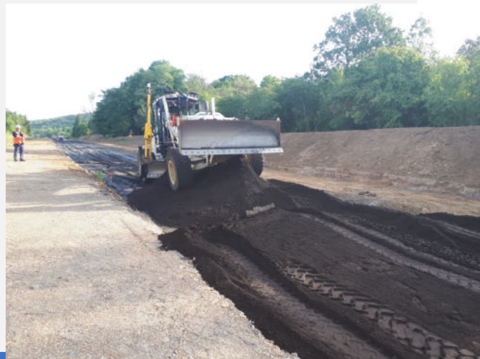
Sable ferreux traité au liant hydraulique – Chantier de Malzéville (54)
